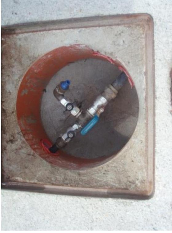
Ubicados en el piso y en una arqueta se encuentran : La llave de corte suministro mas ( 2 ) tomas de llenado mediante ( enchufe rápido ) y otra de rosca  $\frac{1}{2}$  pulgada o  $\frac{3}{4}$  . Pd. El grifo del exterior para cargar agua potable con rosca de  $\frac{1}{2}$  pulgada
